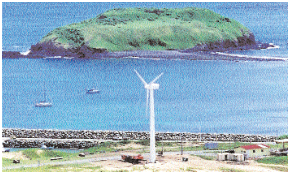
Turbina de geração em Fernando de Noronha
