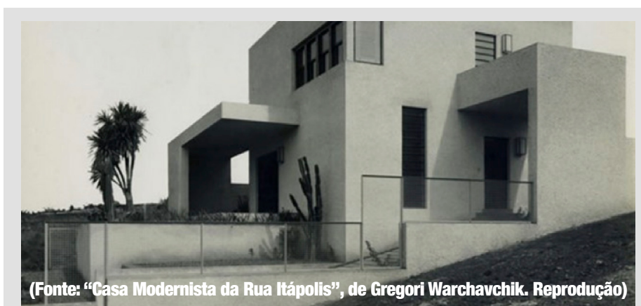
Figura 1. Casa modernista de Warchavchik possui base quase quadrada de oito metros e trinta e cinco centímetros por oito metros e vinte e cinco centímetros, produzindo volume prismático de dois pavimentos de alturas quase iguais.
